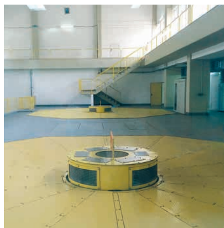
Машинный зал до начала реконструкции
