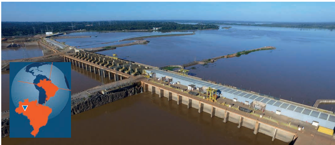
Окрестности здания ГЭС и плотины
