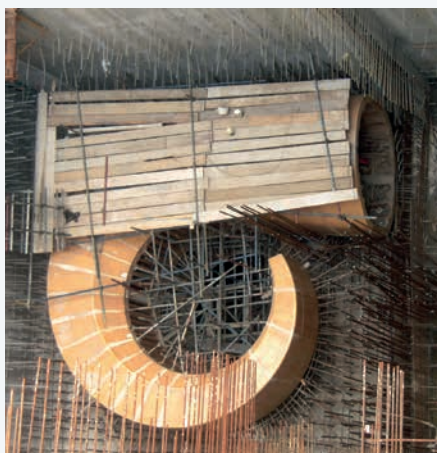
Бетонирование на месте
