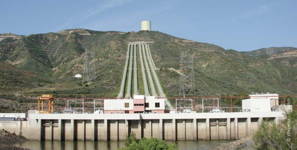
Planta hidroeléctrica de acumulación y bombeo Castaic, Condado de Los Ángeles, California, EE.UU.
