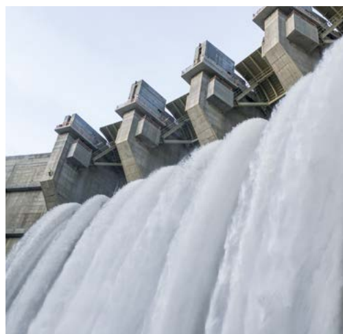
Planta hidroeléctrica almacenamiento y bombeo Foz Tua, Portugal
