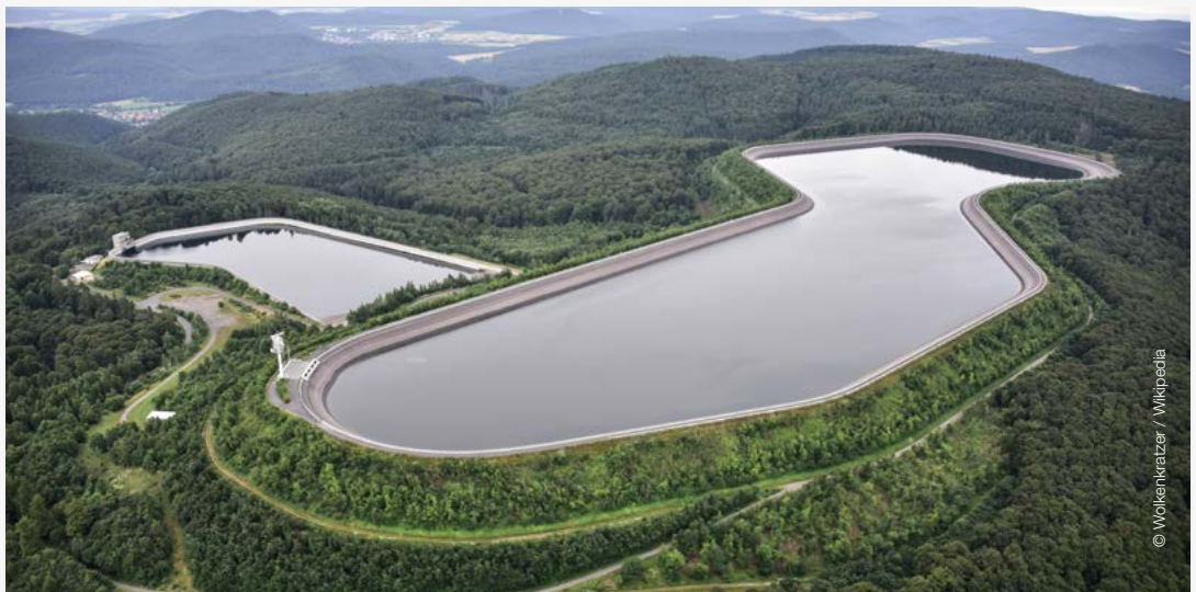
Uniper Kraftwerke GmbH / Alemania ha instalado los sistemas en la planta hidroeléctrica de almacenamiento y bombeo Waldeck 1 (una turbina-bomba de 70 MW) y Waldeck 2 (dos unidades ternarias, cada una de 240 MW) en 2017
