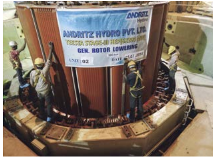
Descenso del rotor del generador
