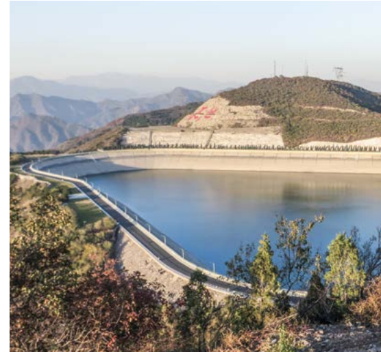
Planta hidroeléctrica de almacenamiento y bombeo Shi Shan Ling, China
