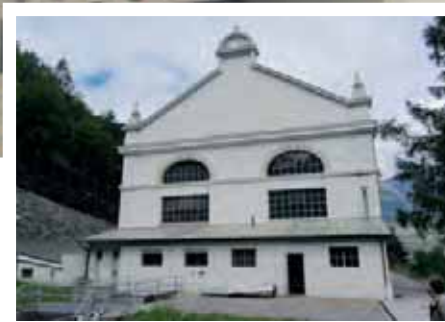
▣ Casa de máquinas
