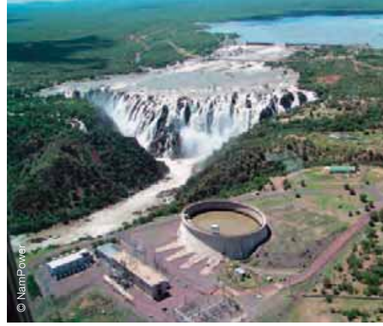
▣ Vista aérea de la central hidroeléctrica Ruacana
