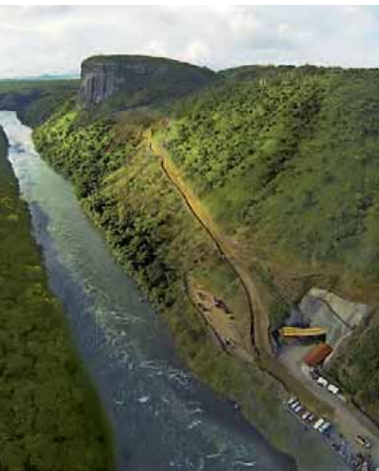
▣ Río Kwanza y el futuro acceso a la casa de máquinas de la CH Laúca
