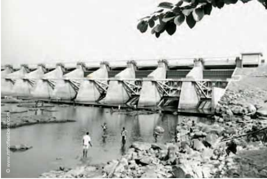
▣ Presa Mount Coffee en su condición original
